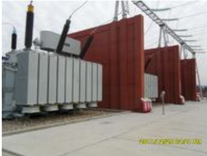
220 kV impedance matching power transformer Máy biến áp phối hợp trở kháng 220 kV
